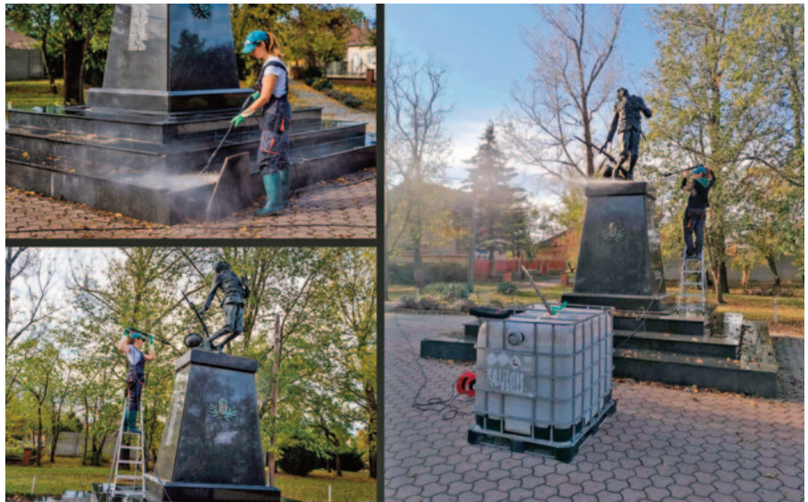
A felületekre rakódott szilárd és lazán kötődő szennyeződések eltávolítása magasnyomású mosóval
