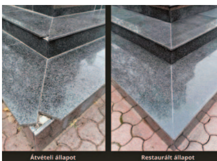
A felfagyott, törmelékessé vált csemperagasztó-maradványok és a vízkőlerakódások eltávolítása
