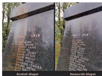
A felfagyott, törmelékessé vált csemperagasztó-maradványok és a vízkőlerakódások eltávolítása
