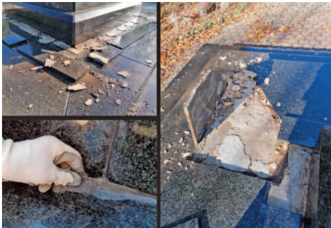
A felfagyott, törmelékessé vált csemperagasztó-maradványok és a vízkőlerakódások eltávolítása
