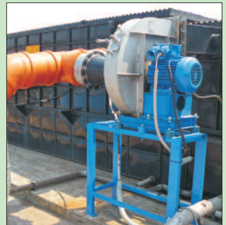
Zárt vezetékben vezetik a szagot a biofilterbe
